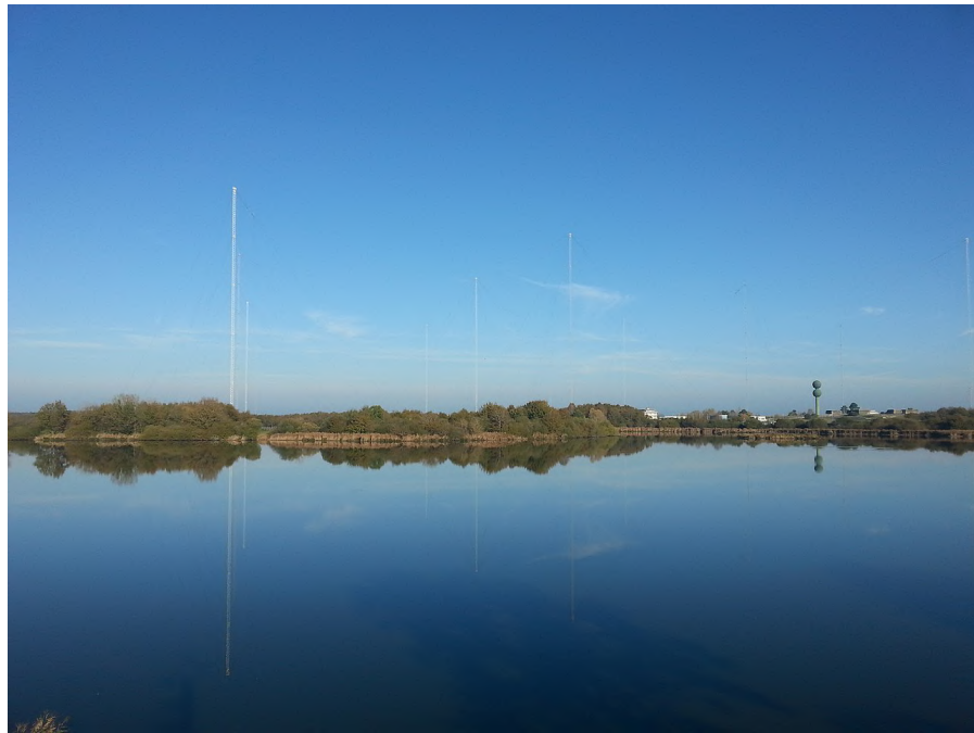
Figure 2.12 – Centre de transmissions de la Marine nationale de Rosnay [11]
