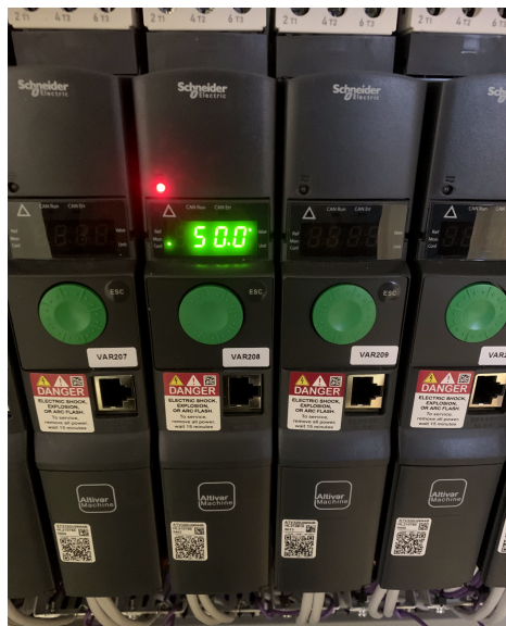
3.2.e.1 Photo de variateur allumé affichant la configuration de la fréquence de rotation maximale
