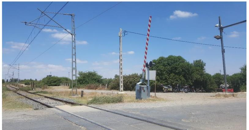
**Figure 9 :** Demi-barrière du passage à niveau de Mchraa Bel Ksiri
